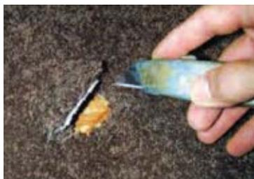
1. Pour installation sur du tapis, découpez d'abord un trou de 2-3/8 po de diamètre dans le tapis avant d'utiliser la sauteuse.
